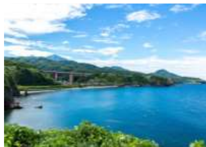
米山と米山大橋
