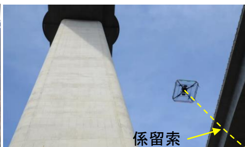
高架橋の点検
