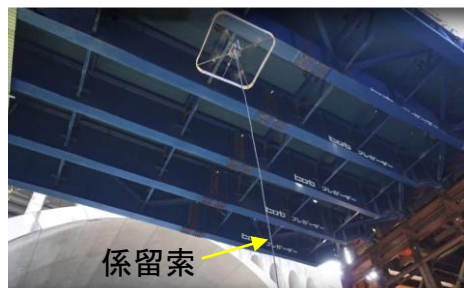
橋梁下の点検
