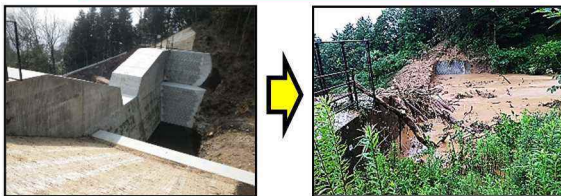
【令和2年7月豪雨】砂防堰堤が土砂と流木を捕捉
