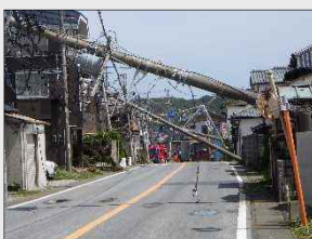
＜令和元年房総半島台風による被害＞
