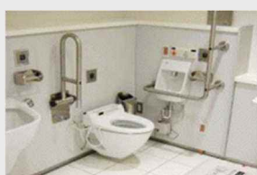
多機能トイレの整備
