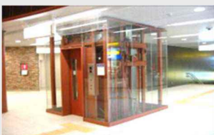
段差の解消（エレベーター）
