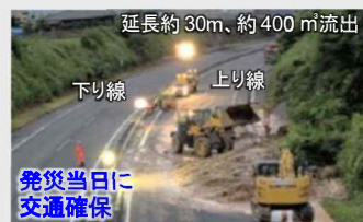
【大分自動車道 九重IC～湯布院IC】 九重IC～湯布院IC間の上り線で路肩崩壊が発生し、並行する国道210号も同時に被災。一時交通が寸断されたものの、大分自動車道の下り線を対面通行として活用することで、発災4日後に広域交通を確保
