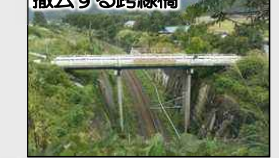
撤去する跨線橋
