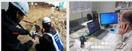
遠隔での現場確認の実施
