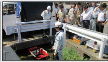
■点検技術の現場実証
