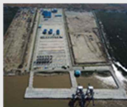
ミャンマー・ティラワ港多目的ターミナル(令和元年6月開港)
