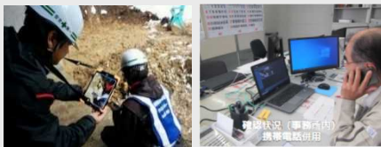
遠隔での現場確認の実施
