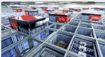
自動倉庫型ピッキングシステム
