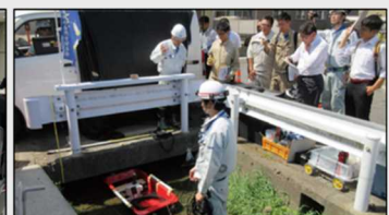
■点検技術の現場実証
