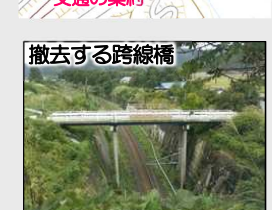
老朽化が進んだ跨線橋を撤去し隣接橋へ機能を集約
