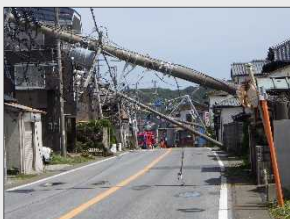
＜令和元年房総半島台風による被害＞
