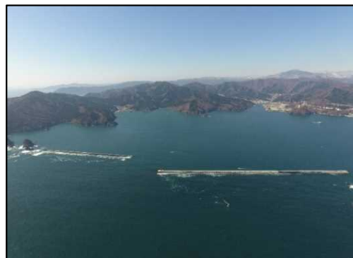
釜石港(湾口防波堤全景)
