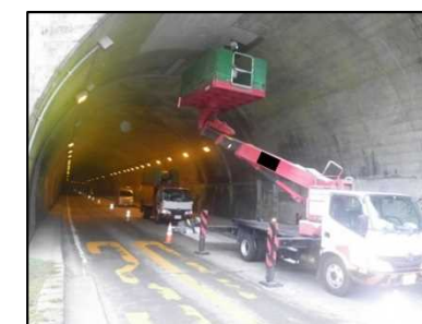
【作業状況（全景）】
