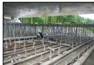
【くさび支保工】
