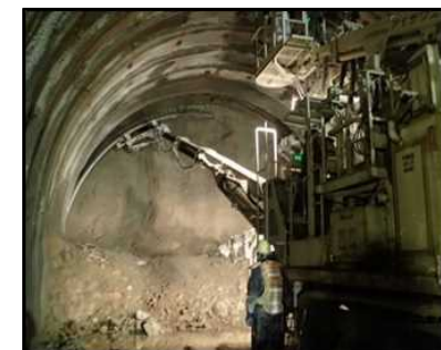
【コンクリート吹付機（エレクトラ装置付）による鋼製支保の建込状況】
