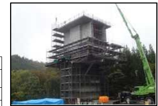
【柱頭部施工状況】
