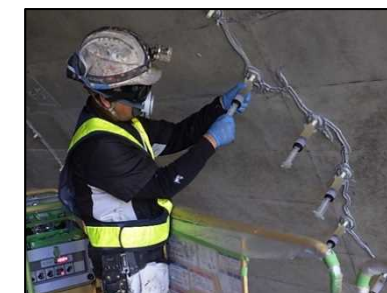
【補修材の注入状況】
