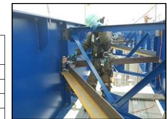
【上部工設置状況】
