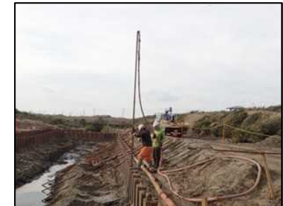
【ウェルポイント設置状況】
