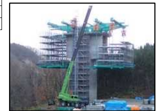
【張出し施工状況】
