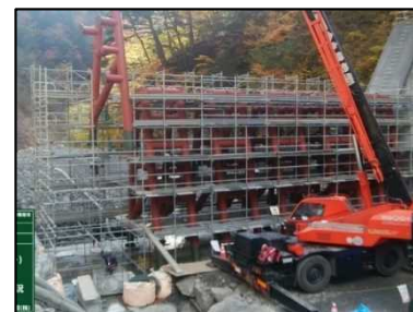
【鋼管フレーム型砂防堰堤】
