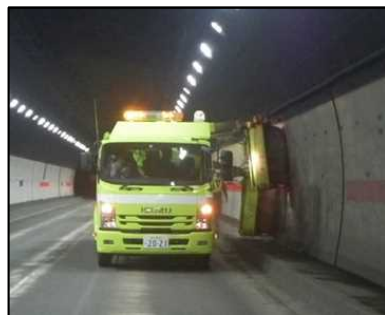
【壁面清掃状況】
