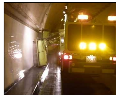
【壁面清掃状況】
