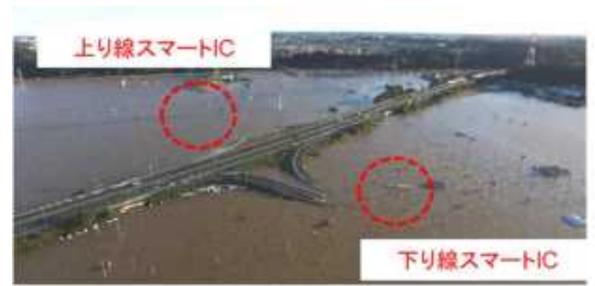
E 6 常磐自動車道 水戸北 S I C冠水 (10月13日時点)
