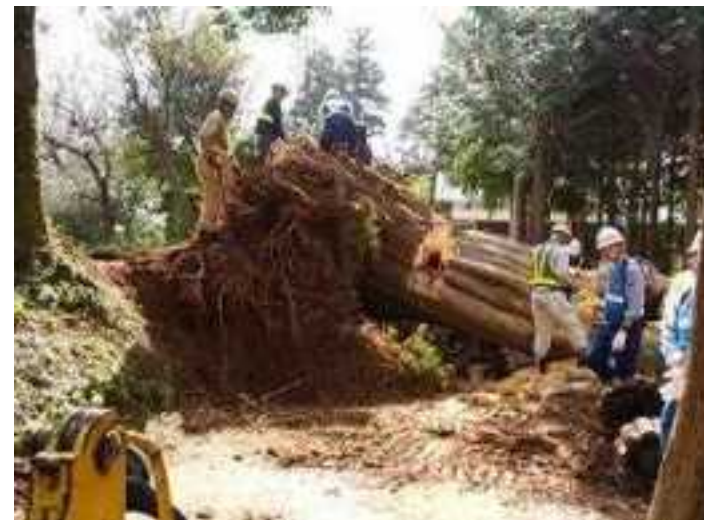
市道における倒木除去を実施(香取市)
