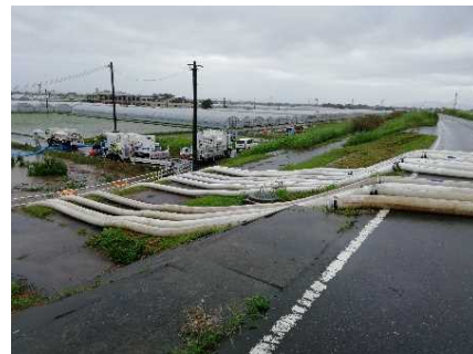
7月7日 排水状況 (福岡県久留米市)
