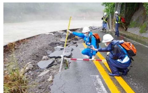
7月7日 国道219号の被災状況調査 (熊本県球磨村)
