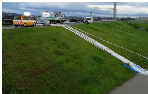
7月7日 排水状況 (福岡県みやま市)
