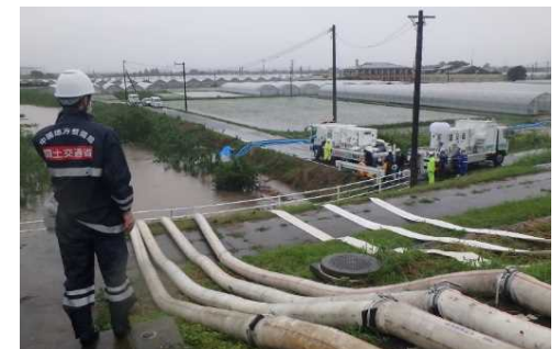
7月6日 排水状況 (福岡県久留米市)
