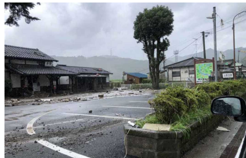
7月6日 渡駅周辺の被災状況 (熊本県球磨村)
