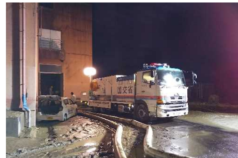
7月4日 排水状況 (熊本県人吉市)
