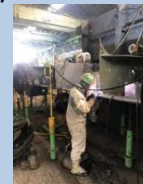
溶接作業の様子
