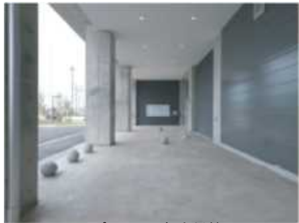
ピロティ(津波対策) (石巻港湾合同庁舎(宮城県))
