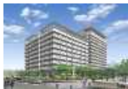
高松サポート合同庁舎
