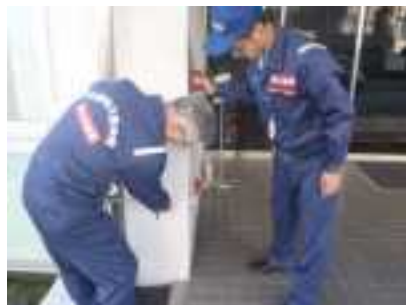
高知地方合同庁舎の現地活動状況写真
