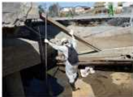
官庁施設の被災状況調査
