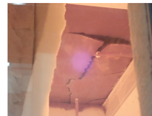
試験体Aの状況 (加熱30分時) 大きな亀裂が観測される。
