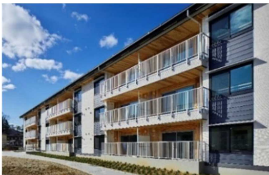
CLTパネル工法による公営住宅 (福島県復興公営住宅 磐崎団地)
