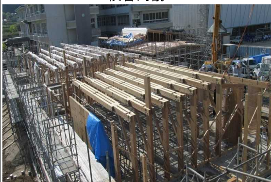
校舎建設工事状況
