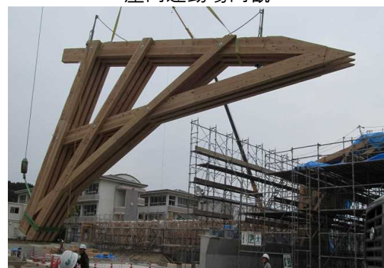
屋内運動場建設工事状況
