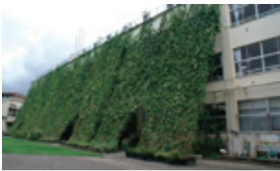
ヘチマのスクリーン：夏快適な校舎の壁面緑化 中島根小学校（東京都）
