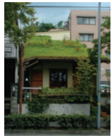
緑の草屋根が個性を演出する喫茶店 コーヒー麓（兵庫県）
