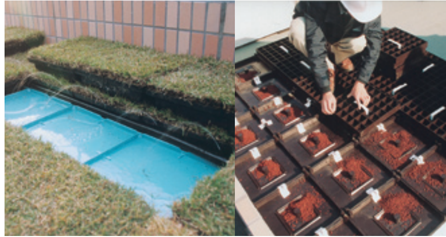
【ユニット型の植栽基盤】屋上緑化の施工性を高めるため各種のユニット型の植栽基盤が開発されています。底面に貯水層を設け、水を効率的に活用しています。
