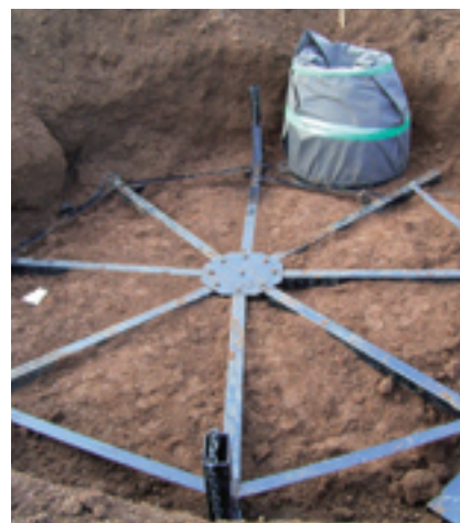
【地下支柱】屋上では軽い土壌による高木の転倒を防ぐため地下支柱が活用されます。
