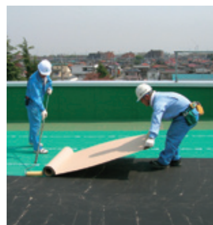
【防根材の設置】屋上緑化では植物の根が建物に影響を及ぼさないように防根材を設置します。
