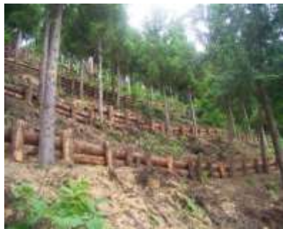
間伐材を活用した山腹保全工
