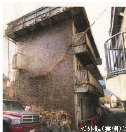
外壁、手すりが崩落した事例
