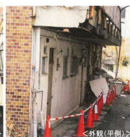
外壁、手すりが崩落した事例
