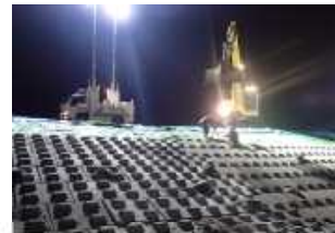
緊急復旧工事状況【9月10日】
