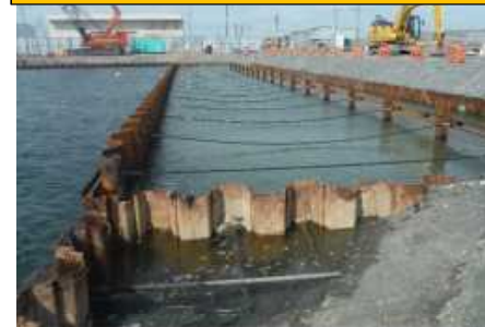
東港区物揚場(-3m) 本體工完成状況
