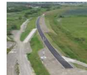
被災堤防の本復旧については、7月30日に完了。
