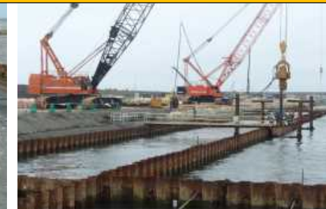
東港区物揚場(-4m) 鋼矢板打設状況
