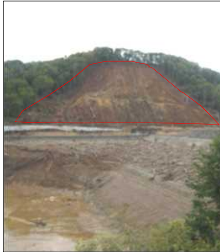
【新鷗川地区】川西幹線用水路 流入した土砂による開水路の閉塞
