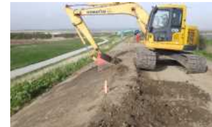
切り返し盛り土が完了した箇所から順次、整形を実施。
