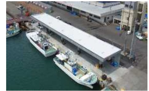
水産物の輸出促進のための屋根付き岸壁等の整備促進 (苫小牧港:H30.4一部供用開始)
