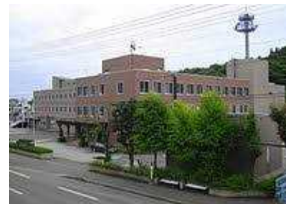
重要インフラの緊急点検(官庁施設)
