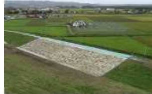
緊急復旧工事完了【9月13日】
