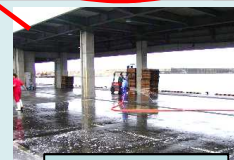
清浄海水導入施設
