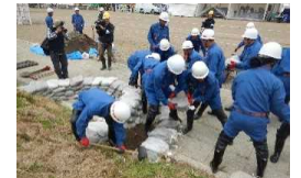
漏水対策工法(月の輪工)
