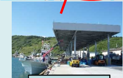
屋根付き岸壁
