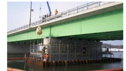
(緊急輸送路上の橋梁の耐震補強)
