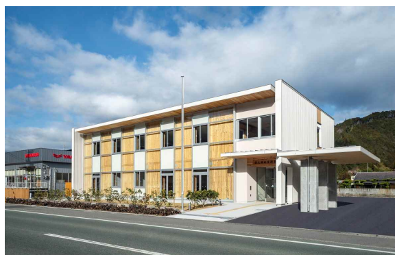
嶺北森林管理署 【CLTパネル工法】
