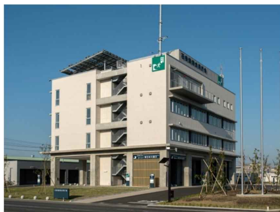
【津波対策を実施した官庁施設の例（石巻港湾合同庁舎）】
