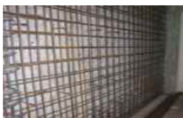
耐震壁増し打ち
