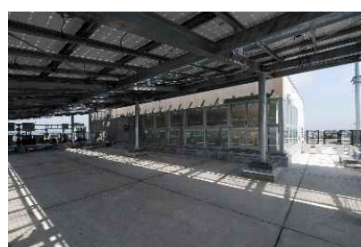
屋上津波避難スペース併設
