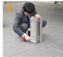
2 中間支柱を取付けます
