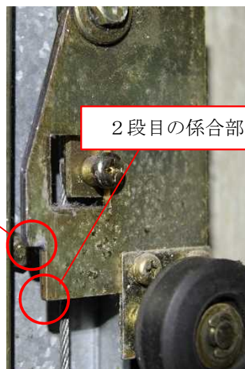
写真7 可動ロック装置の係合部
