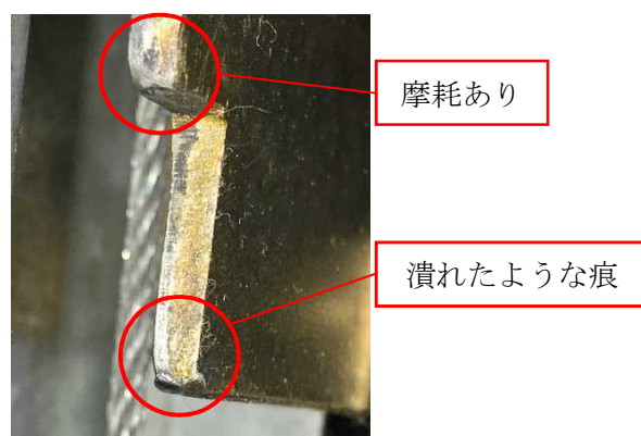
写真10 1階の固定ロック装置 写真11 3階の可動ロック装置の係合部
