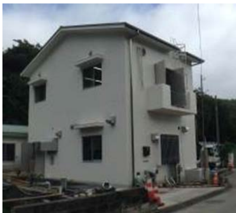
沖村浄水場管理棟（母島）
