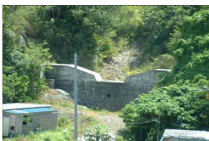
八ツ瀬川砂防施設
