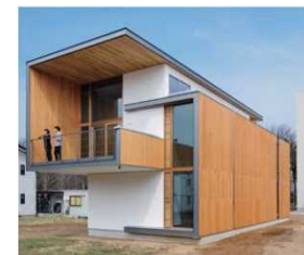
CLT工法による実験棟
