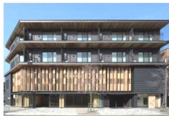
木質耐火部材を使用した耐火建築物
