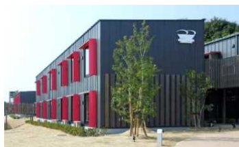
CLT工法による木造ホテル
