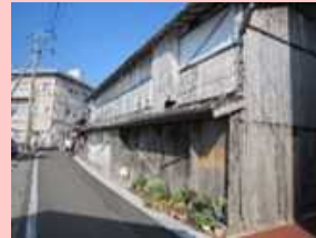
空き家の除却
