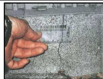
水平器による柱の傾きの計測
