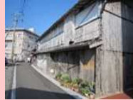
空き家の除却
