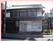
空き家の活用
