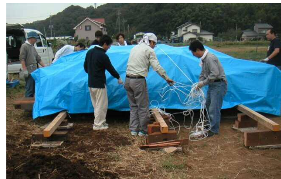
市民活動の様子/旧三井別邸(大磯町) 解体保存した部材の養生作業
