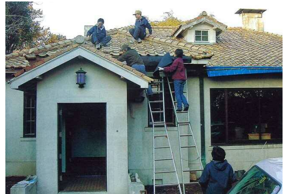
市民活動の様子/旧モーガン邸(藤沢市) ボランティアによる雨漏りの応急修理
