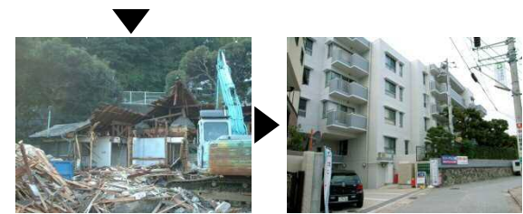
旧三井守之助別荘(大磯町) 2003年に解体保存され、マンションが建設
