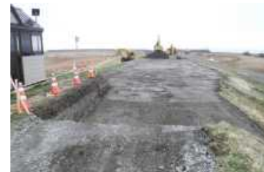
切り返し工が完了した箇所は順次、盛り土施工を開始。
