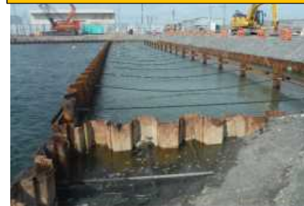
東港区物揚場(-3m) 本體工完成状況
