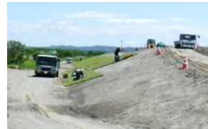
整形完了後、植生を実施。
