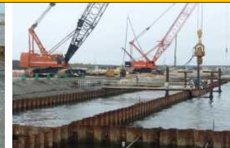
東港区物揚場(-4m) 鋼矢板打設状況
