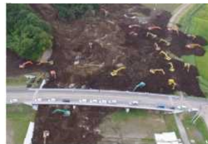
河道閉塞した厚真川の緊急復旧作業
