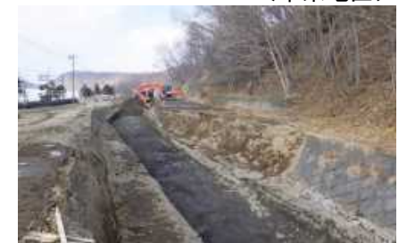
農業水利施設の復旧
