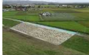
緊急復旧工事完了【9月13日】
