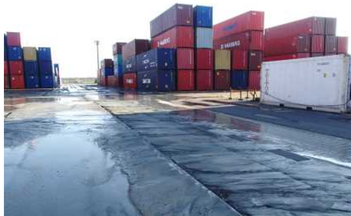
コンテナヤードの液状化
