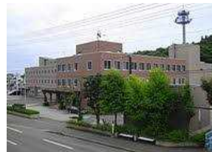
重要インフラの緊急点検(官庁施設)
