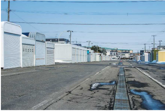
▲住宅地への車両の出入りを制限するために設けられた集中駐車場（通称：車庫通）
