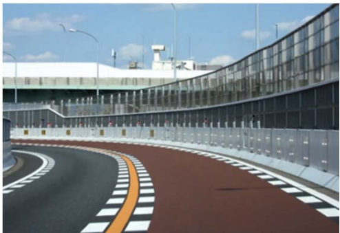
事故多発区間への対策例（カラー舗装）
