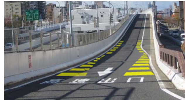
逆走防止対策例（黄色カラー舗装）
