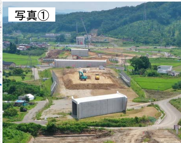
▲道路改良工事の施工状況
