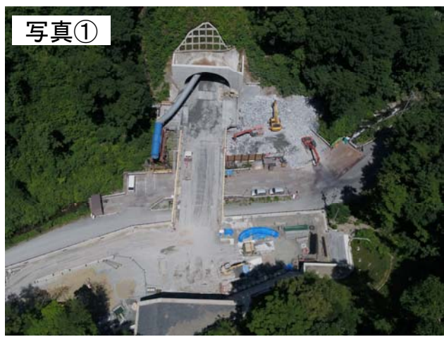
▲ (仮称)与部沢トンネルの施工状況
