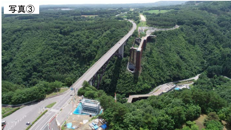
▲ (仮称)新思惟大橋の施工状況(全景その2)
