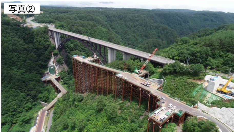
▲ (仮称)新思惟大橋の施工状況(全景その1)
