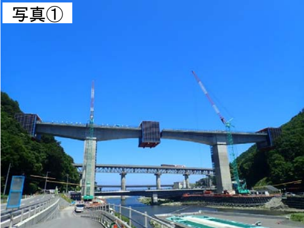
▲（仮称）新坂家大橋上部工の施工状況
