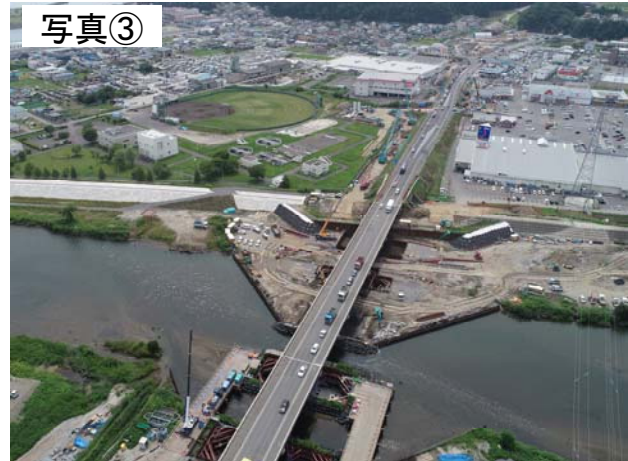
▲ 久慈大橋下部工の施工状況
