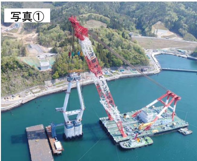
▲(仮称)気仙沼湾横断橋 海上部主塔架設状況(R1.5月)
