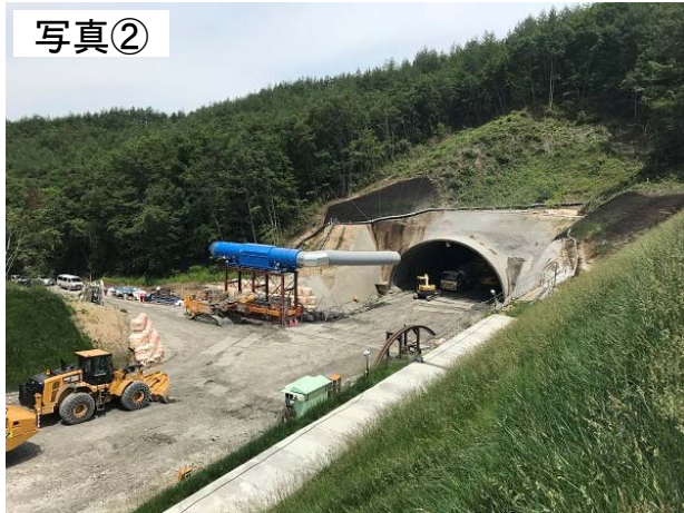
▲（仮称）久慈長内トンネルの施工状況
