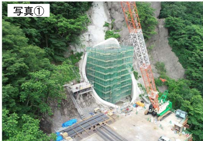
▲ (仮称)新思惟大橋下部工の施工状況
