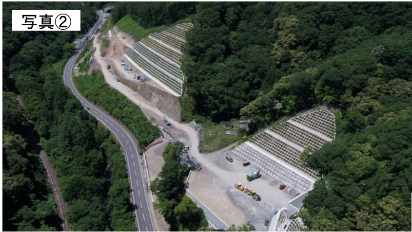
▲道路改良工事の施工状況
