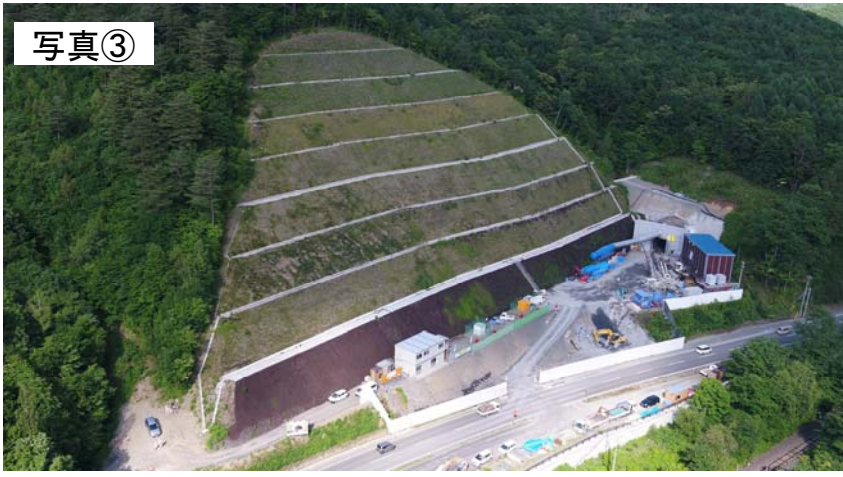
▲ (仮称)松草トンネルの施工状況
