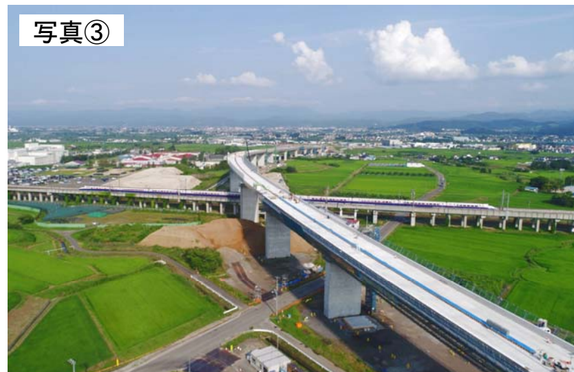
▲（仮称）桑折高架橋の施工状況
