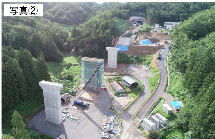
▲（仮称）掛田橋下部工の施工状況
