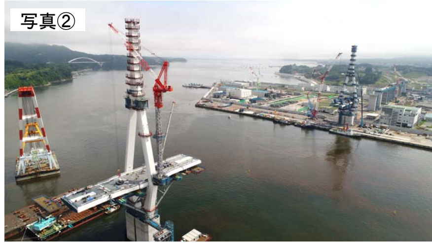
▲(仮称)気仙沼湾横断橋の上部工施工状況(海上部)
