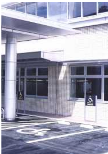
車いす利用者用 駐車場の整備
