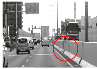
写真11 事故地点付近 (○部分は衝突の痕跡を示す。)
