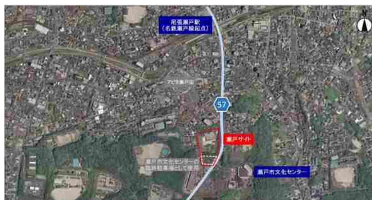
図 1-2-2 瀬戸サイトの周辺状況
