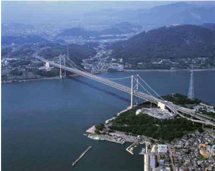
(資料) 関門地域（下関市・北九州市）の未来をつなぐ下関北九州道路（平成 30 年 7 月）
