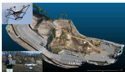
①ドローン等による3次元測量
