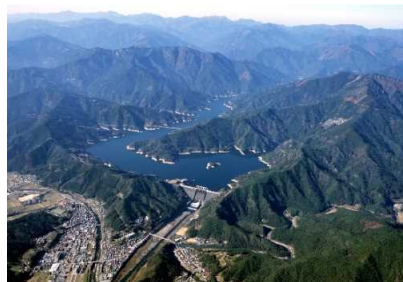
早明浦ダム (出典:水資源機構 池田総合管理所ウェブサイト、早明浦ダムパンフレット)
