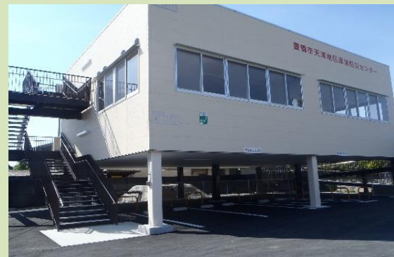
浸水を想定したピロティー形式の防災センター【豊橋市】
