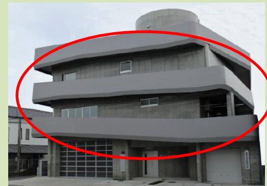
公共施設の建替えに合わせた避難機能の追加 (消防署建替えに合わせ避難スロープ設置)【鎌倉市】
