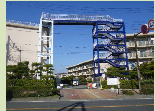
既存施設(市営住宅)へ避難階段設置【藤沢市】 その他、民間施設への補助事例あり (屋上部避難場所設置)
