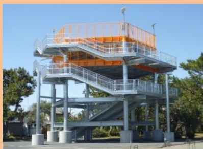
津波避難タワー等の避難施設
