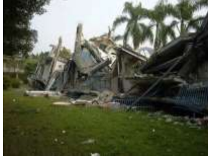
写真g 地表断層上のRC構造物の傾動
