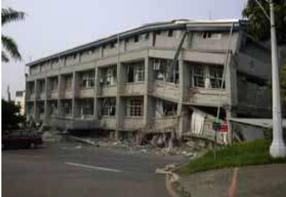
写真f 1階部分が倒壊した台湾省の図書館
