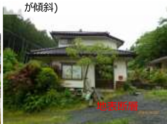
写真 10 断層上と推定される木造家屋(左側沈降)
