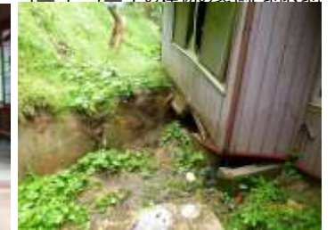
写真 8 木造建築(左端が断層で地盤傾斜有)
