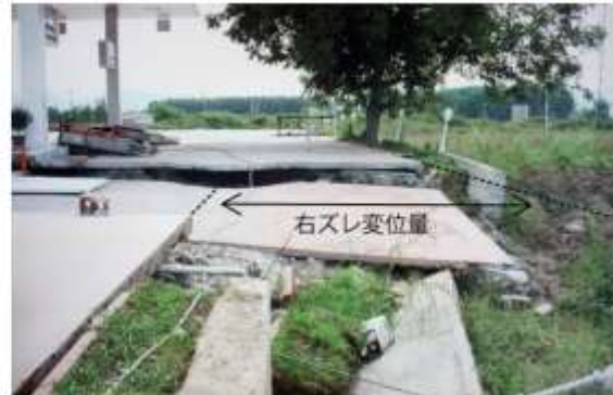
北アナトリア断層直上のガソリンスタンドの被害状況
