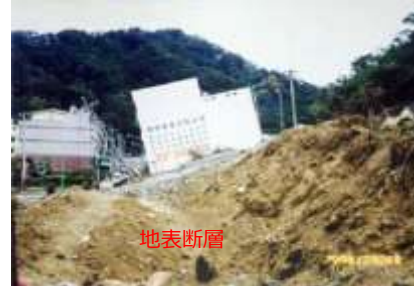
写真g 地表断層上のRC構造物の傾動
