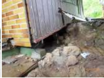
写真 6 木造建築(右端の断層で建物が傾斜)
