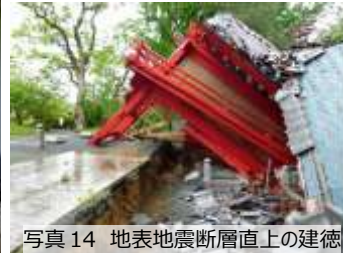
写真 14 地表地震断層直上の建徳寺山門の倒壊
