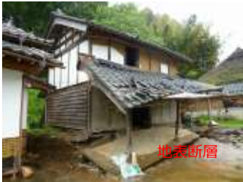
写真 9 木造建築(直下の地表地震断層で傾斜)
