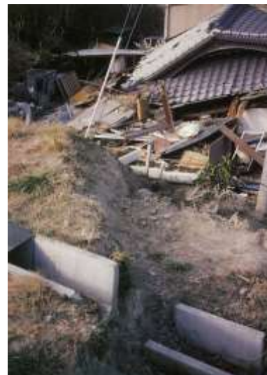
写真 j 地表断層上の木造家屋の倒壊
