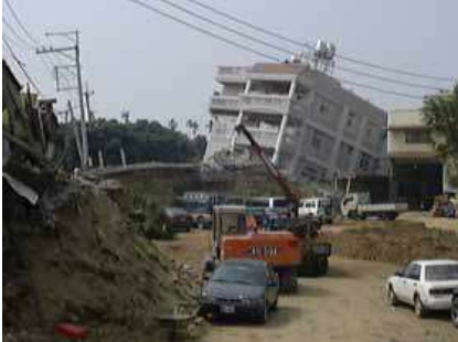
写真f 1階部分が倒壊した台湾省の図書館
