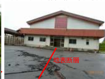
写真 11 断層に隣接する木造家屋(左側沈降)
