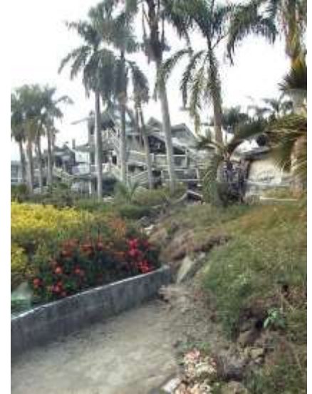
写真h 地表断層のずれにより被害を受けた小中学校
