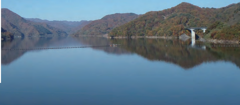
摺上川ダム貯水池
