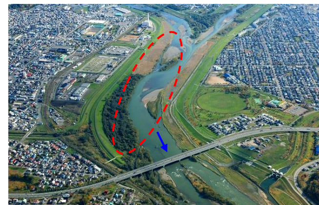
河道掘削・樹木伐採予定箇所（石狩川）
