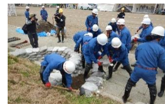
漏水対策工法(月の輪工)
