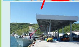
屋根付き岸壁
