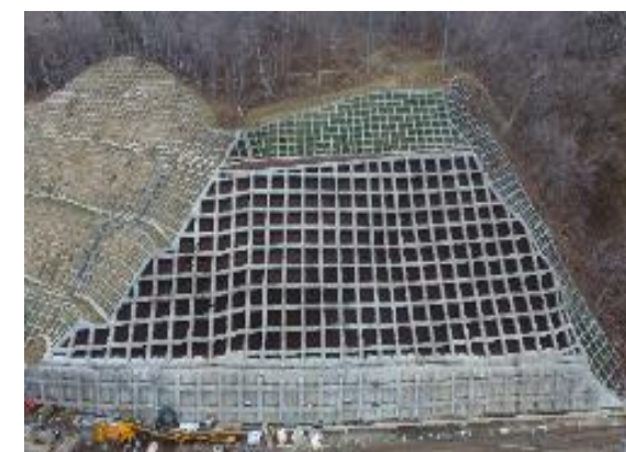
道路の法面对策
