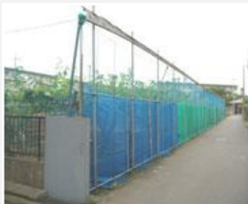
農業飛散防止施設の整備
