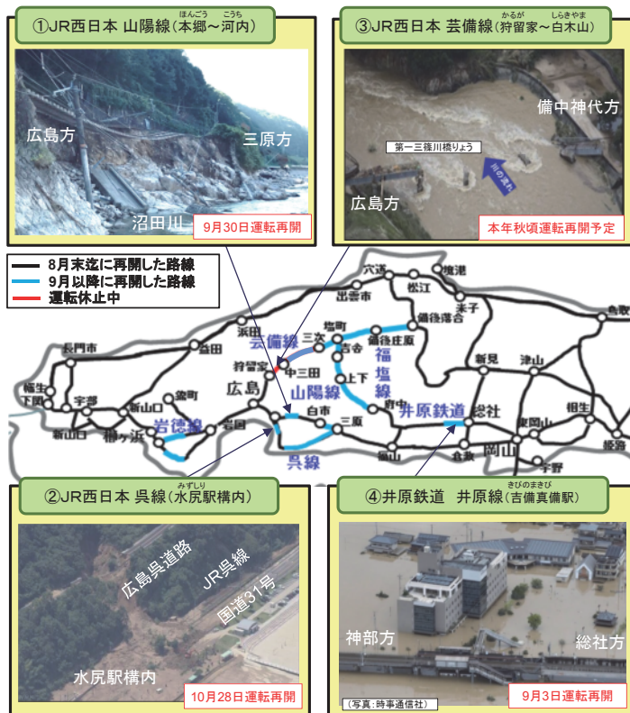
図表1-2-2-14 平成30年7月豪雨による鉄道の主な被害状況 (2019年5月時点)
