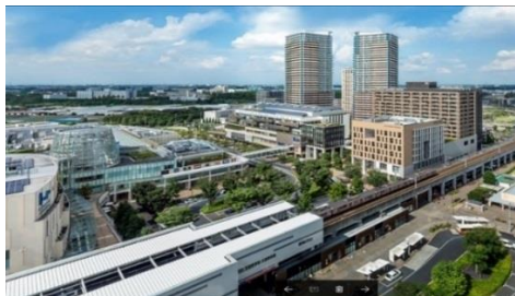
〔柏の葉キャンパス駅とマンション外観〕
