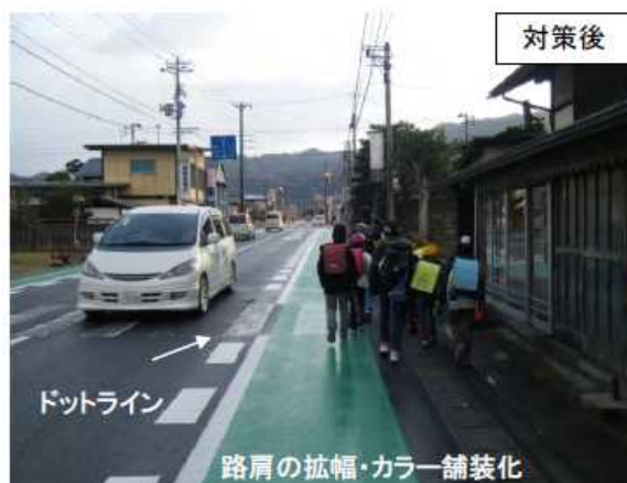
路肩のカラー拡幅、カラー舗装化
