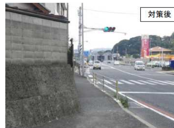
防護柵の設置
