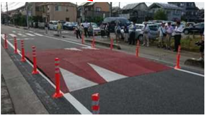
仮設ハンプ・狭さく設置(H30.7.24~7.30)
