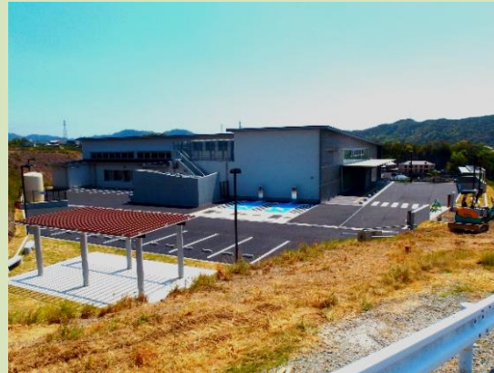
高台の防災センター【日高川町】
