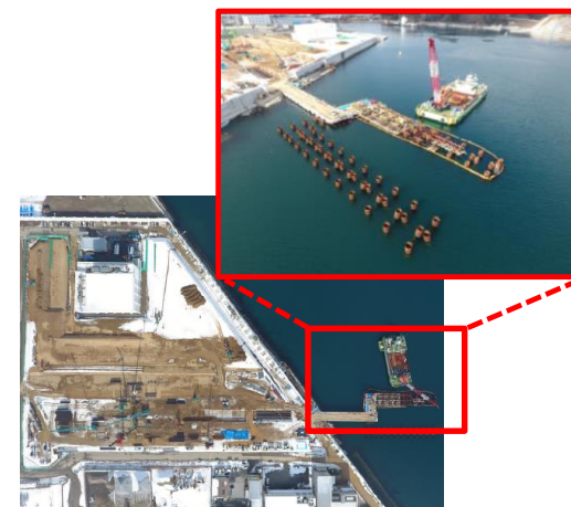
建造中の造船工場(H30.2現在)
