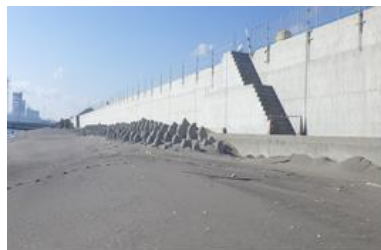
仙台塩釜港海岸(宮城県)
