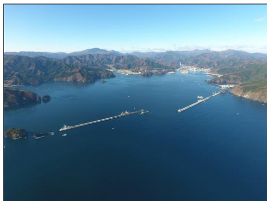
H29.12 釜石港湾口防波堤全景
