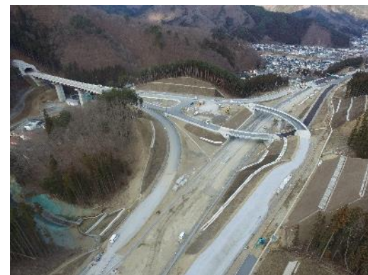
三陸沿岸道路 釜石南～釜石両石（釜石JCT） （2019.1現在）
