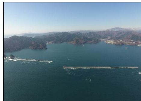
釜石港 (湾口防波堤全景)
