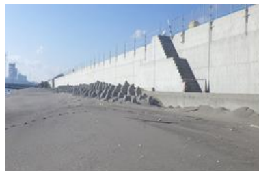
仙台塩釜港海岸(宮城県)
