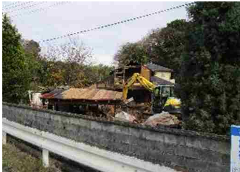
写真2:屋根が崩壊した空き家(荒尾地区)
