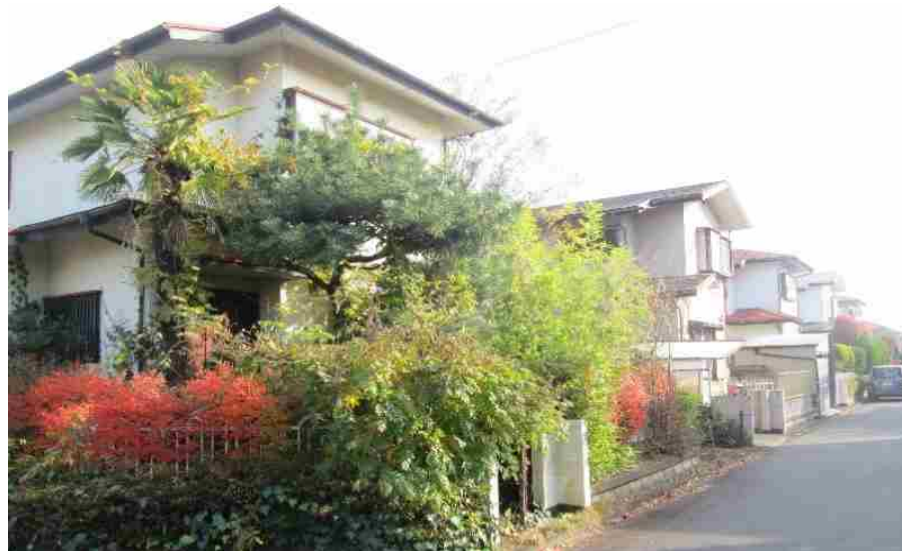
写真2: 道路沿いで放置された空き屋
