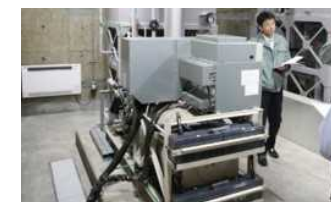
非常用電源の設置
