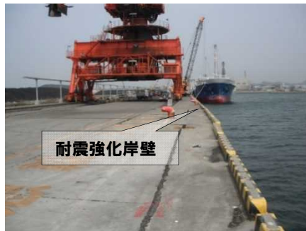
○東日本大震災における耐震強化岸壁と一般岸壁の被災状況(小名浜港の例)
