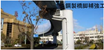
橋脚補強工
