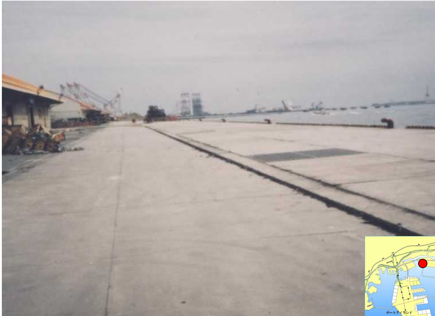
摩耶埠頭(出典:近畿地方整備局神戸港湾事務所)
