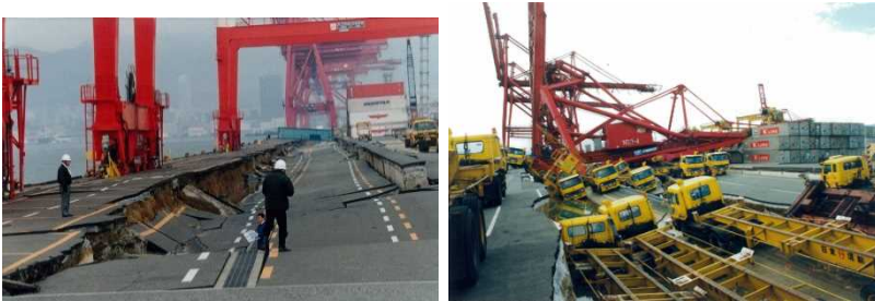
○東日本大震災における耐震強化岸壁と一般岸壁の被災状況(小名浜港の例)
