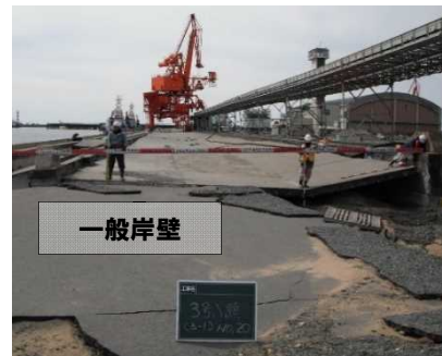
○東日本大震災における耐震強化岸壁と一般岸壁の被災状況(小名浜港の例)
